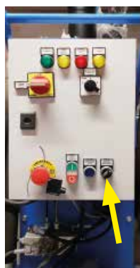
Start/Stop pompa ausiliaria per contatore di particelle Fig.15
