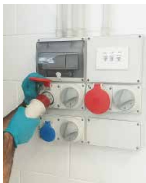
Collegamento elettrico per il motore trifase (spina 5 poli)
